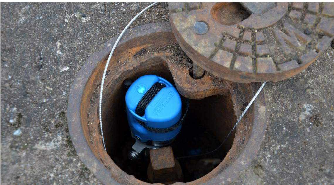
Mithilfe der LPWA-Funktechnologie sind die „SmartEAR“-Sensoren von SebaKMT in der Lage, selbst unter schwierigen Bedingungen, wie beispielsweise in metallischen Schächten, ihre Messdaten zuverlässig und energieeffizient an die Cloud-Plattform „POSEYEDON-Cloud“ zu senden.
